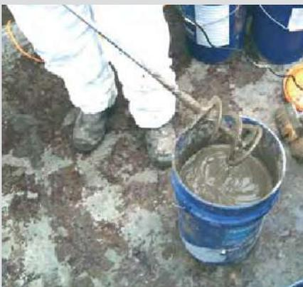
Mezclar Penetron Standard en una "papilla" espesa y melosa
