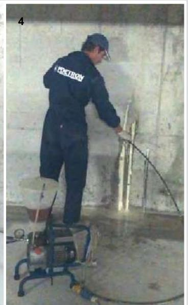
Foto 1) Lesión por derrame de agua bajo presión hidráulica - Foto 2) Preparación de los orificios para los empacadores de inyección - Foto 3) Fijación de los empacadores de sellado en los orificios Foto 4) Inyección por bomba eléctrica de la resina elástica hidroexpansible.
