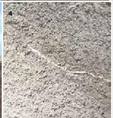
**Foto 1)** Impermeabilización por pulverización de hormigón de un perfil de túnel ferroviario deteriorado - **Foto 2 - 3)** Impermeabilización por pulverización de hormigón contra los pilotes de un aparcamiento subterráneo **Foto 4)** Crecimiento del vehículo de humedad cristalina en las grietas y porosidad residual de la pulverización de hormigón.
