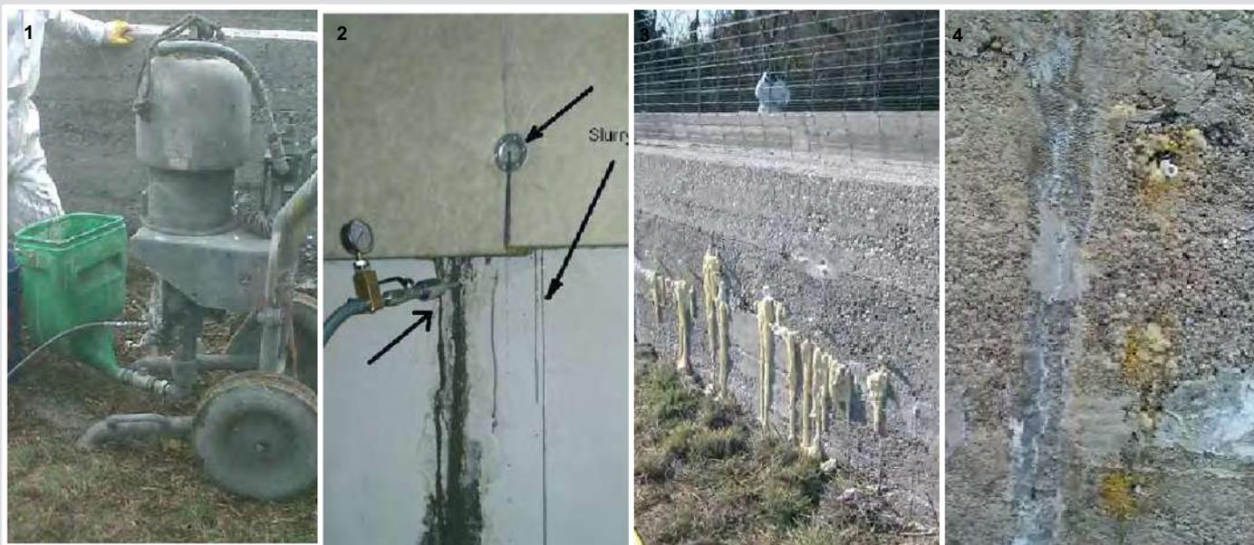
Foto 1) Mezcla de los dos componentes Penetron Inject en una bomba de lechada de cemento fluido - Foto 2) Preparación de los inyectores e inyección de la lechada viscosa a presión - Foto 3) Penetron Inject se puede utilizar en combinación con resinas de poliuretano elásticas e hidroexpansivas Foto 4) Reacción del sellador cristalino en una grieta
