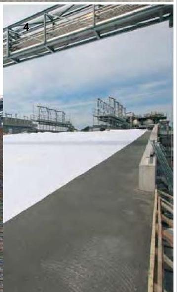
Foto 1) Desempolvado de superficies horizontales recién vertidas - Foto 2) Acabado con helicóptero - Foto 3) Pasos de ejecución Foto 4) Maduración húmeda de superficies
